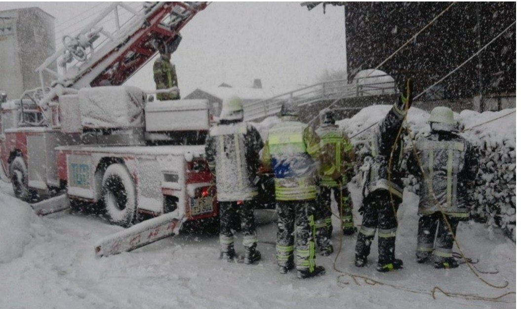
Beide Bilder: 14.01.2019 Schneerräumung von Dächern in Traunstein
