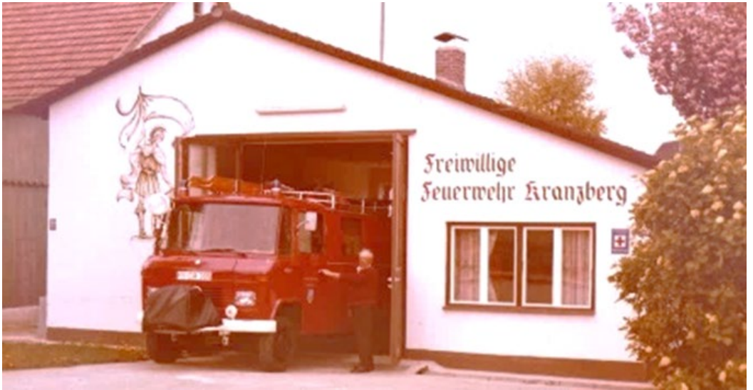
Feuerwehrgerätehaus Untere Dorfstraße 16
