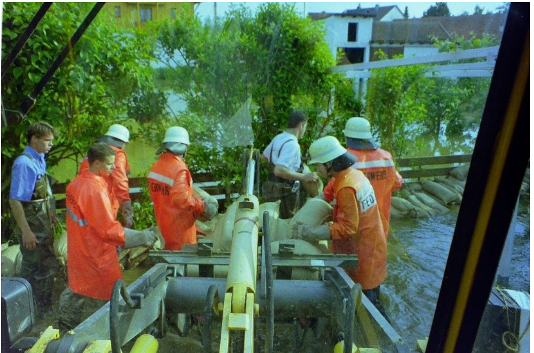
Beide Bilder: 22.05.1999 Pfingsthochwasser; oben: überfluteter Sportplatz, unten: Sandsäckestapeln
