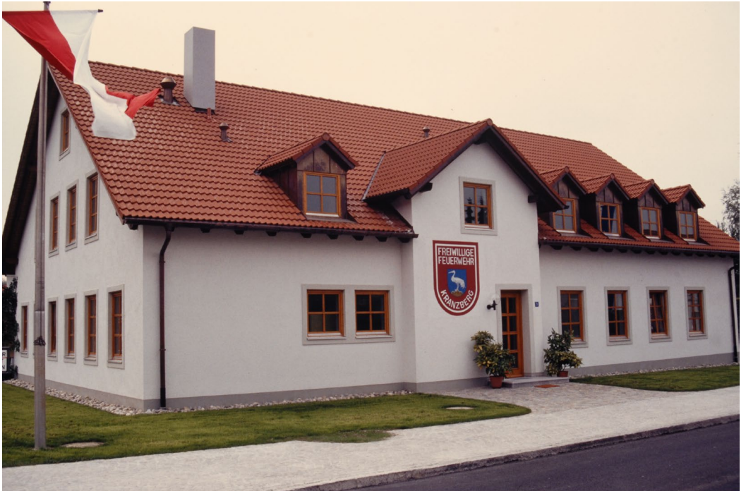
Feuerwehrgerätehaus Untere Dorfstraße 3
